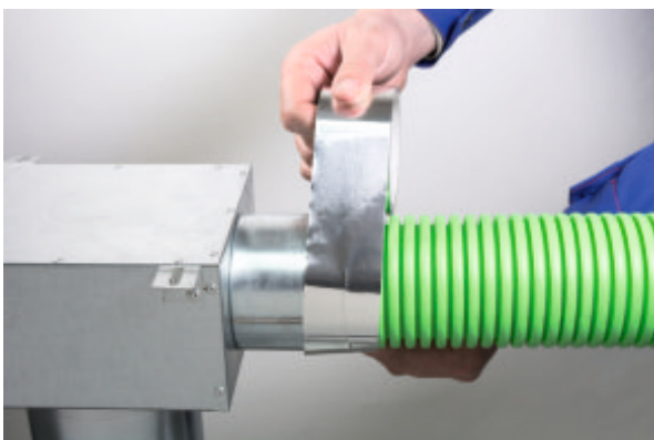
7) Assicurare il collegamento con del nastro adesivo a tenuta d'aria.
